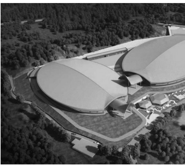
图为五指山天然矿泉水生产基地。
