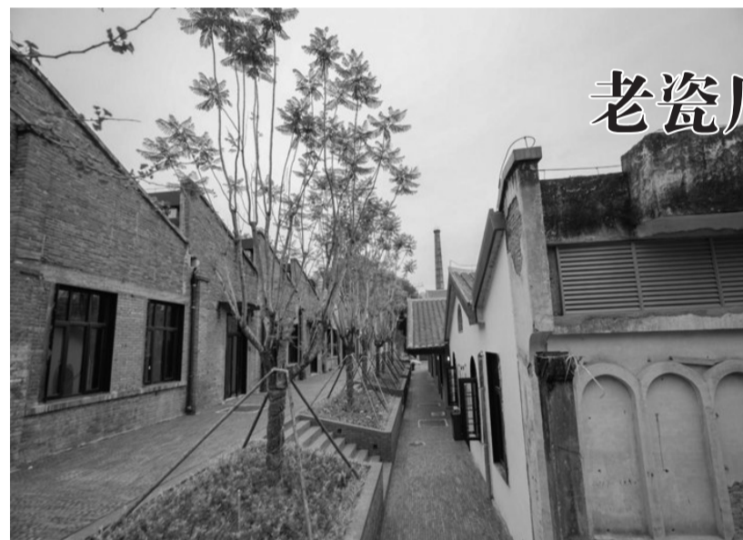
图为改造后的德化红旗坊文旅产业园。
