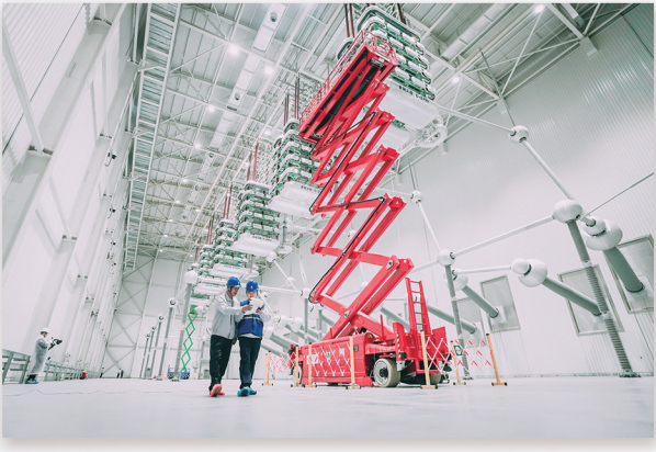
2024年4月18日,国网江西超高压公司检修人员对换流阀进行检修。(龚可欣/摄)
