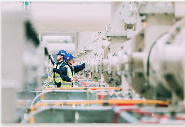
2024年4月18日,检修人员在特高压鄱阳湖换流站GIS室进行设备检修。(龚可欣/摄)
