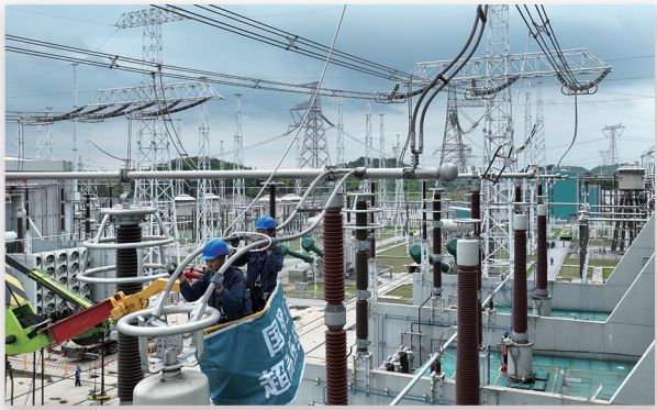
2024年4月18日,国网江西省电力有限公司检修人员在±800千伏特高压鄱阳湖换流站对换流变进行检修。(肖成/摄)
