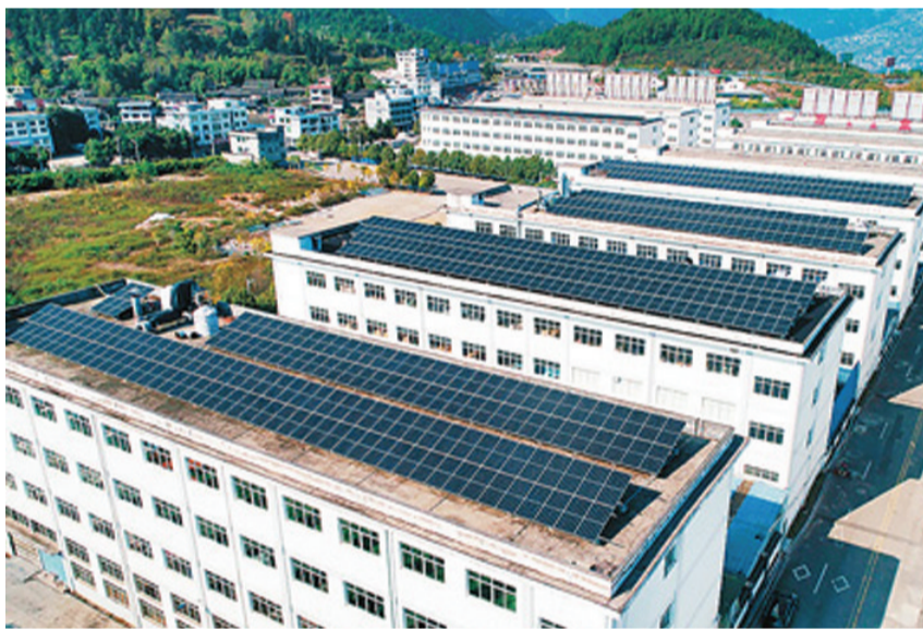
近年来,贵州省铜仁市积极践行绿色发展理念,推动分布式屋顶光伏项目建设,促进可再生能源开发利用。图为在铜仁市印江土家族苗族自治县经济开发区,一幢幢厂房的屋顶布满分布式光伏板,为当地持续输送绿色电力。
