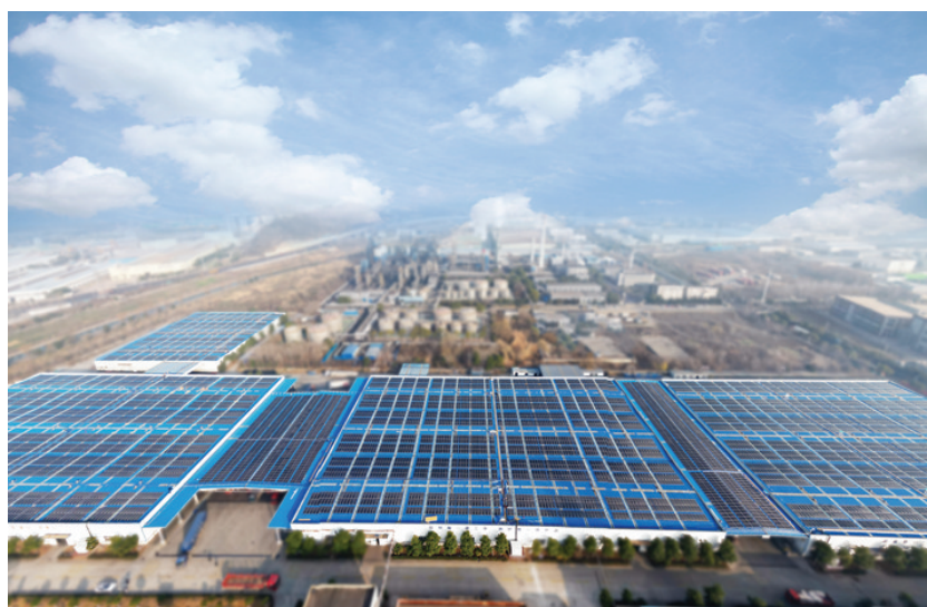
图为马鞍山立白光伏发电建设。
