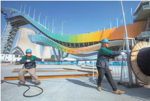
国网北京石景山供电公司员工为冬奥运动场馆首钢大跳台整体用电临电工程进行电缆铺设（李强 摄）
