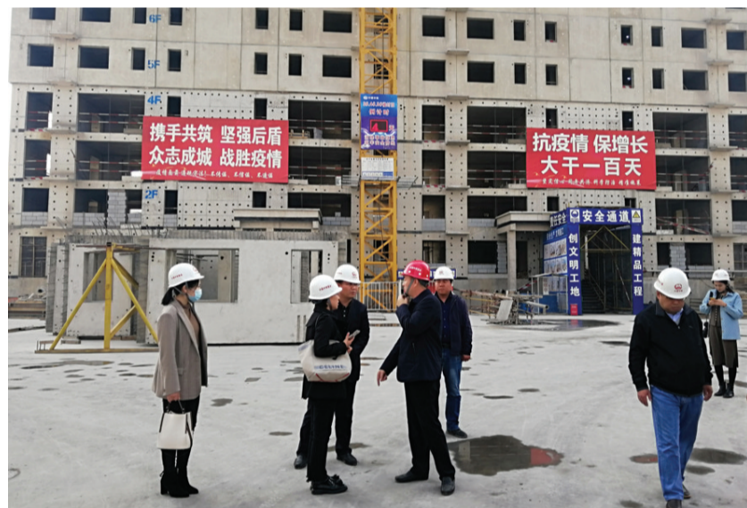
北京诺德彩园共有产权房项目施工现场
