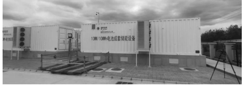
本报讯 (记者 王国荣 □孟繁祥 刘超)近日,记者从平高集团获悉,由该集团承建的天津市滨海区智慧能源小镇创新示范工程中新天津生态城(惠风溪)小镇电网侧储能电站打造成了国内智慧园区优质样板工程。项目依据智慧能源小镇配电网的特点,在小镇中建设规模为10MW/10MWh的集中式储能电站,促进新能源消纳,提高配电网运行灵活性。通过“集中式布置、集中式调控”的方案和标准来开展建设,采用安全可靠的磷酸铁锂电池作为储能技术路线。整站采用户外集装箱式布置方式,该项目的并网将进一步提高大电网故障应对能力,有效降低尖峰负荷,缓解弃风弃光,促进清洁能源消纳。通过虚拟电厂、多能互补等多种手段的结合,进一步提高分布式新能源的友好并网能力以及分布式电源的渗透率,通过对集中储能系统的调度,利用储能的充放电快速、精确响应特性,参
