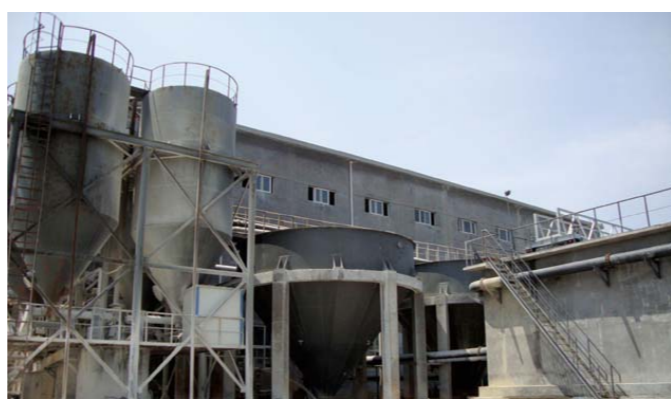
水处理车间外景
