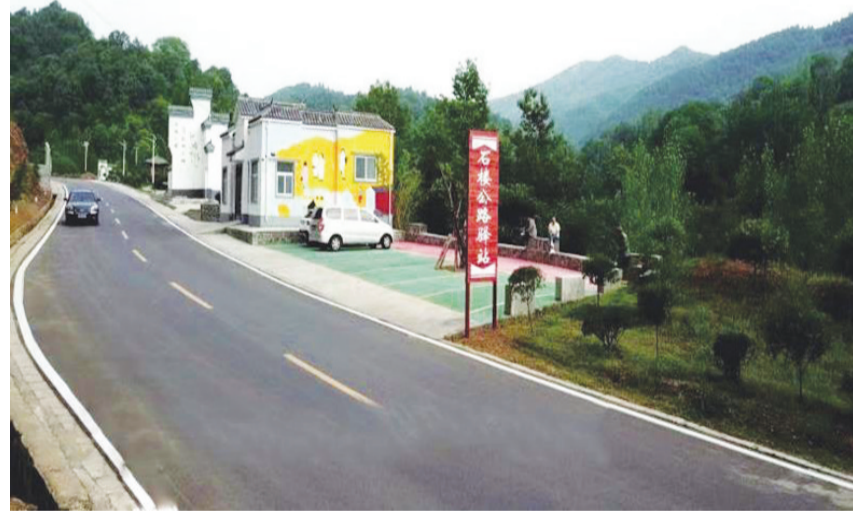
2009年嵩县第一条高速公路洛栾高速公路开始修建,“四纵五横”的交通公路网络格局初步形成。
